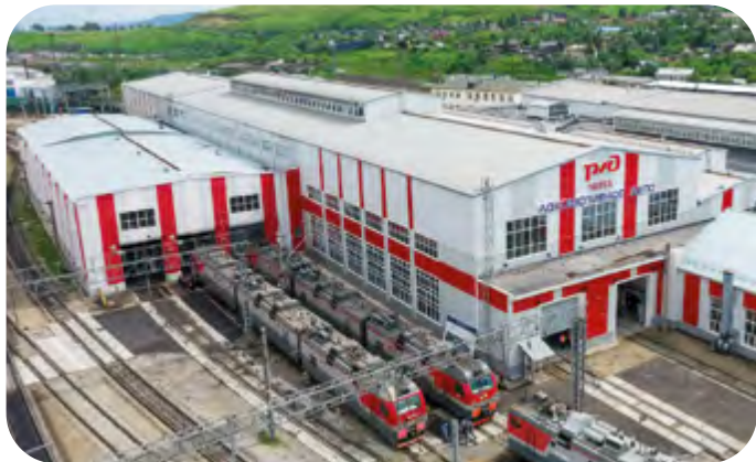
Ремонтное депо РЖД, г. Чита
